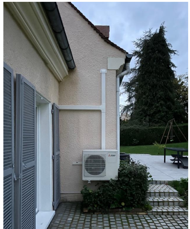
Après la pose
