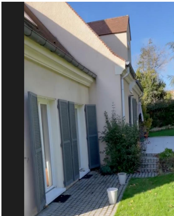
Avant la pose
